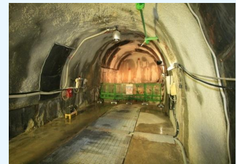
【- 300 m Measurement Niche off V-Shaft】
