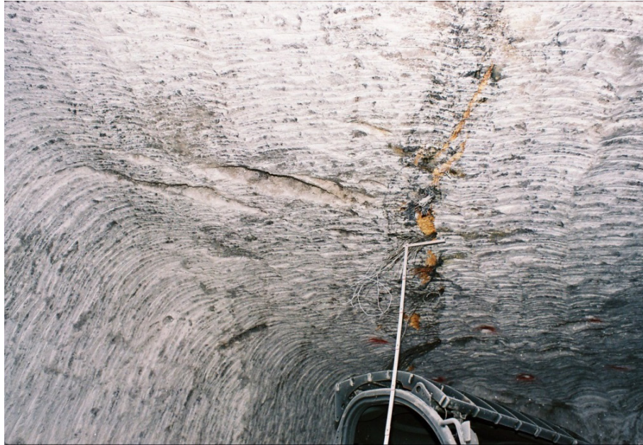
Abb. 13.4 Sohle 637/658 Zugang BS2 unmittelbar nach der Auffahrung – Ehemaliger Schacht, von dem noch das Holz und die Kabel zu sehen sind /ASS 12/
