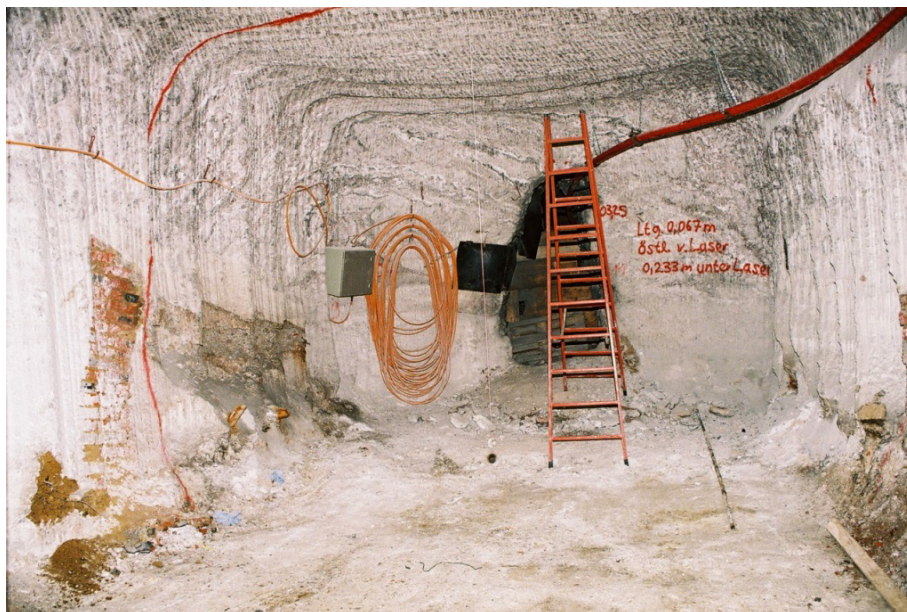
Abb. 13.5 700 m Sohle: Neue Strecke kreuzt ehemalige Strecke (links und rechts zu sehen)
