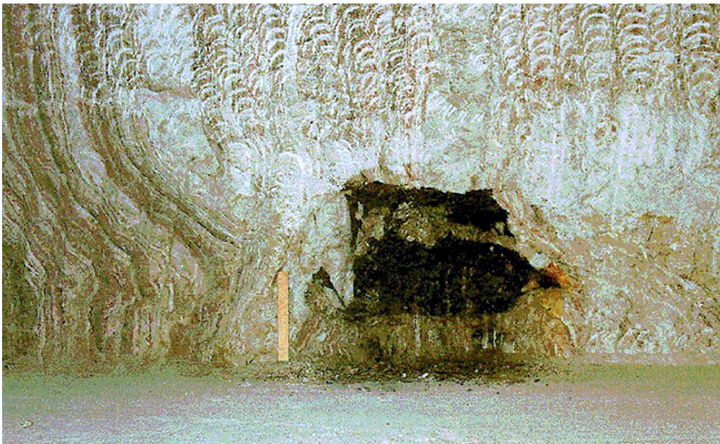
Abb. 4.3 Versatzkompaktion infolge Streckenkonvergenz auf der 750-m-Sohle im ehemaligen Salzbergwerk Asse II /BRE 99/
